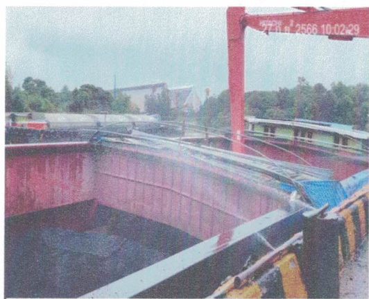
ระบบสเปรย์น้ำทำเทียบเรือใช้งานปกติ
